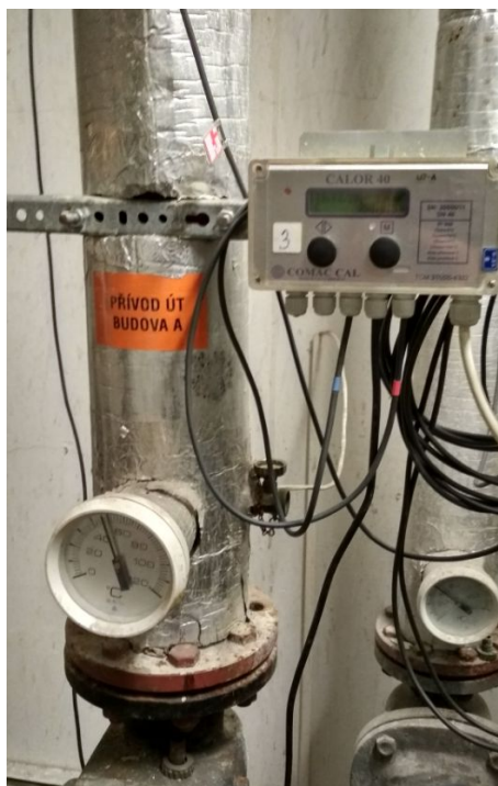
přípojka teplovodu do objektu A
